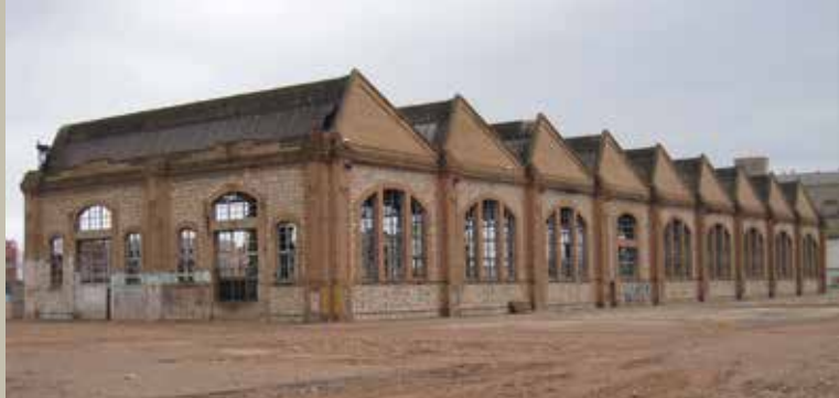
La Nave de Máquinas o Nave Nº 13 salvada del derribo, 2009.
