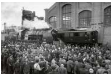
Los trabajadores en el acto de entrega a RENFE de locomotoras de vapor 240 2600 y eléctricas 7409, 1946.
