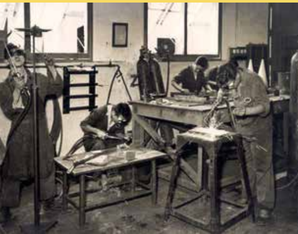
[Abajo] Prácticas de soldadura en el Taller Escuela. El aprendiz de la izquierda está soldando una probeta "a techo" con soldadura autógena, 1955.
