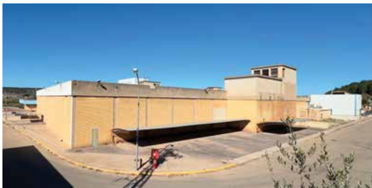
Imagen actual de las antiguas instalaciones de Hilaturas Anna (arriba) y de TAVEX en Navarrés (abajo). Fotos: Manolo Ares, 2024
