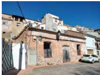
12. TINTES TEXTILES: Edificio en desuso y desmantelado.
