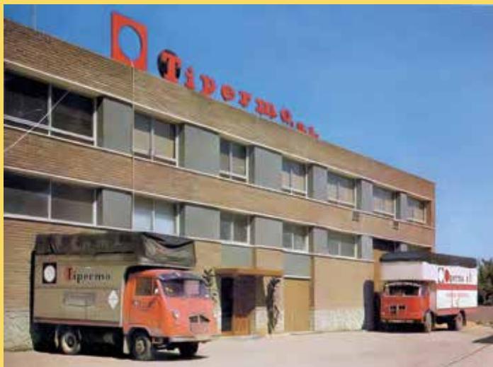
Entrada a la fàbrica.
