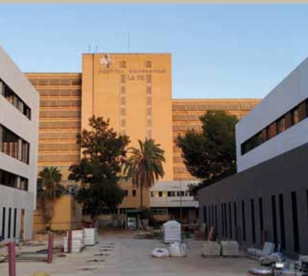
Antiguo edificio del Pabellón Central y, en primer plano, obras de construcción del nuevo centro sanitario multidisciplinar, 2023. Foto: José Durbán.
