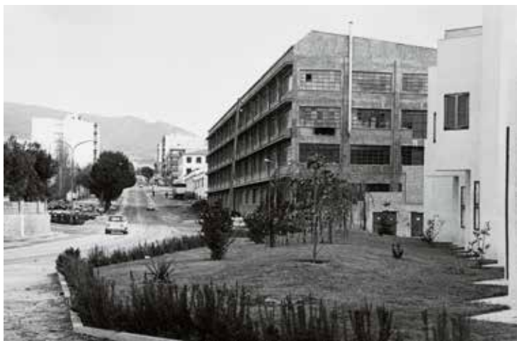
Desvío de la carretera algunos años después de la explosión. Foto: Archivo Municipal de Ibi.
