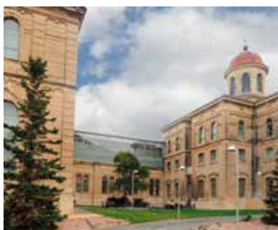
Hospital Civil de Oliver (Alcoi). Foto: Neus Beneyto
