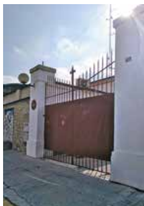
La porta de la fàbrica de Ríos en 2019, poc abans de ser enderrocada.
